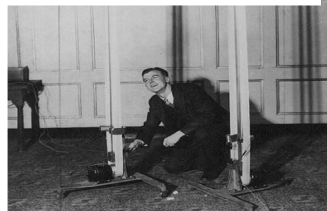
Рис. 2 Генератор Ван де Граафа
