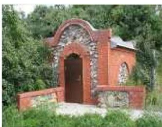
Гидротехническое сооружение - каптаж.
