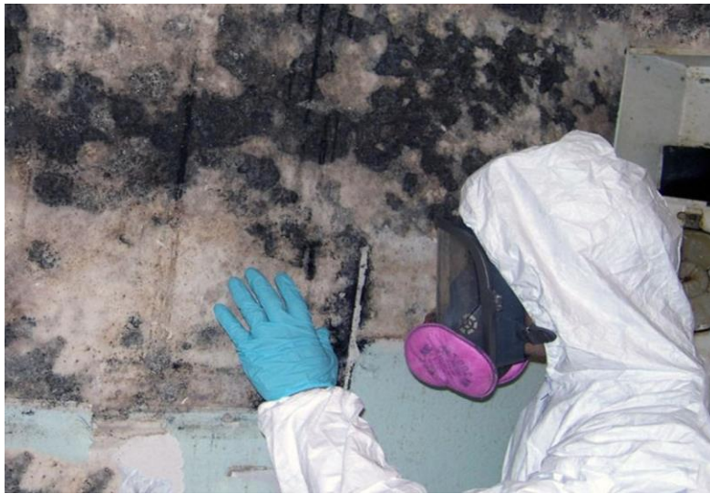
Приложение 3. Плесень на стенах дома.
