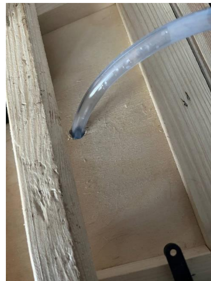
Рис.10. Отверстие под шланг
