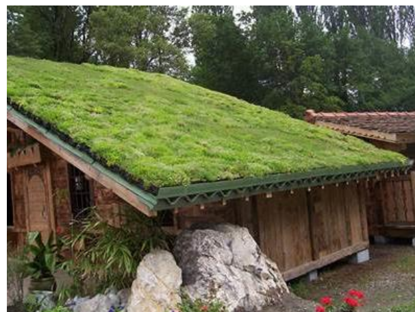
Рис. 2. Экстенсивный способ озеленения крыш
